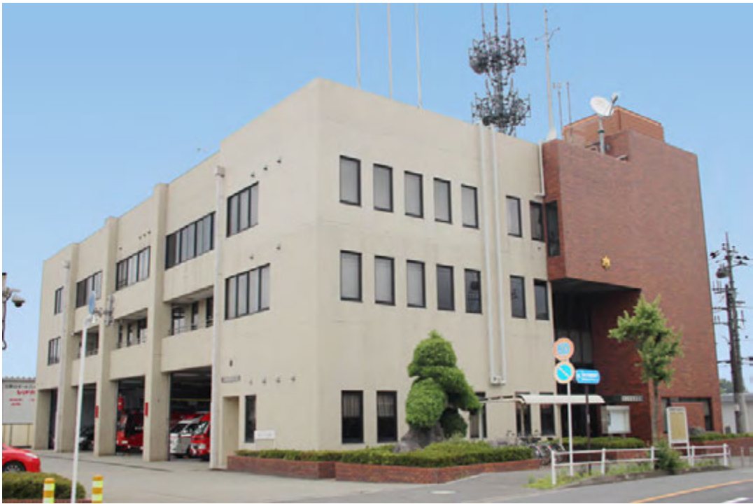
埼玉西部消防局 所沢中央消防署
