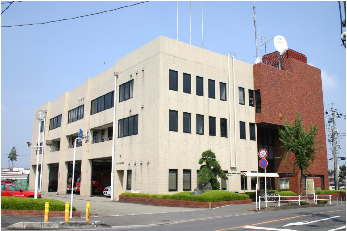
埼玉西部消防局 所沢中央消防署
