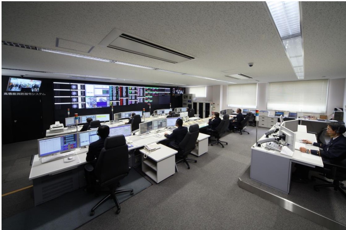
通信指令センター 高機能消防指令システム（Ⅲ型）
