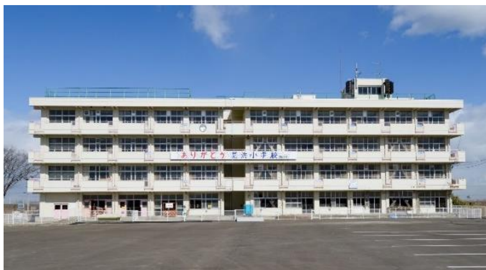
震災遺構仙台市立荒浜小学校
