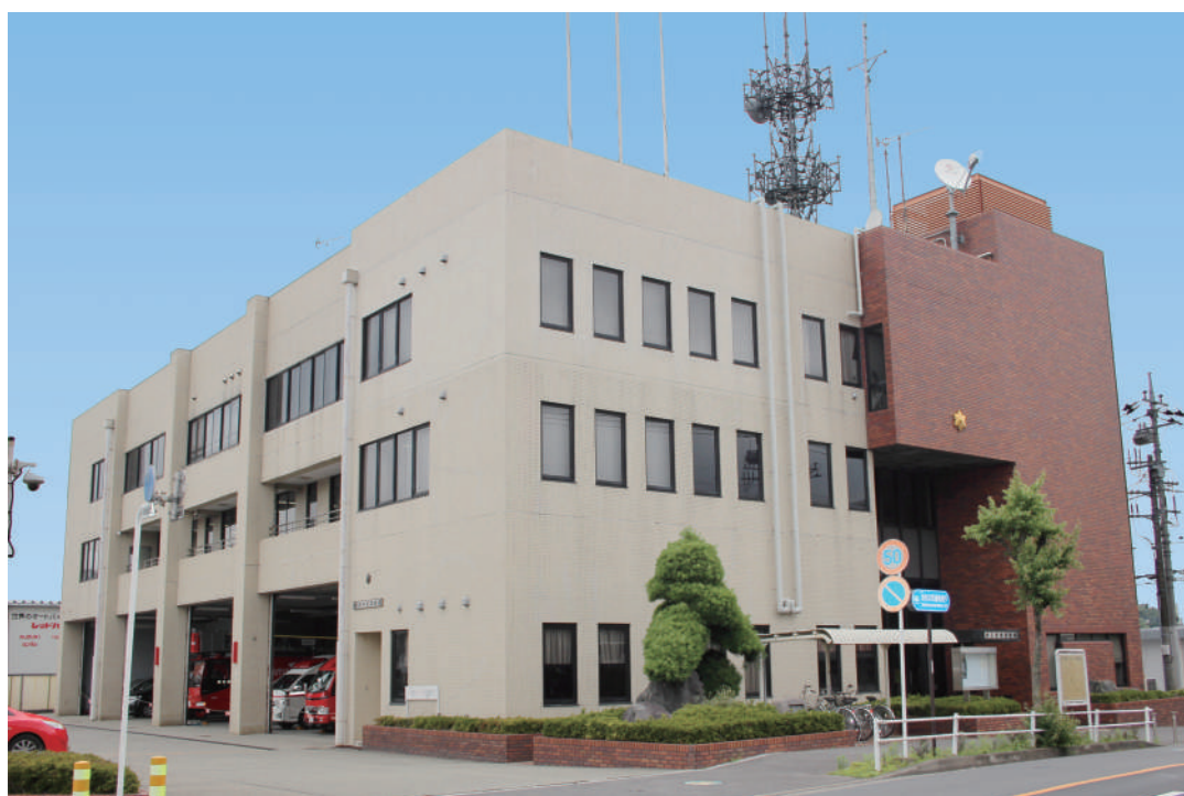
埼玉西部消防局 所沢中央消防署
