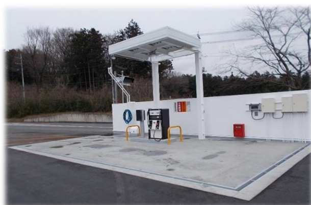
飯能日高消防署の自家給油施設 (緊急防災減災事業債を活用)
