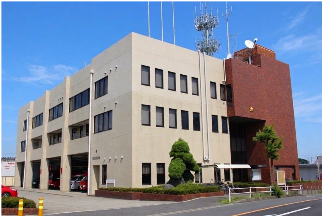
埼玉西部消防局 所沢中央消防署
